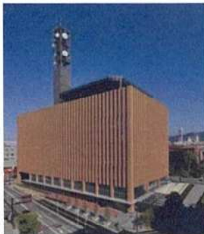
山梨県庁 防災新館 4F大会議室 (409~411)
